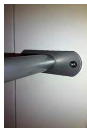
AZ Groeninge Kortrijk : proef- en testopstelling. Bijkomende moeilijkheid, de afKortrijk standhouders moesten hier gemonteerd worden direct op het aluminium raam kozijn d.m.v metaal revetten.
