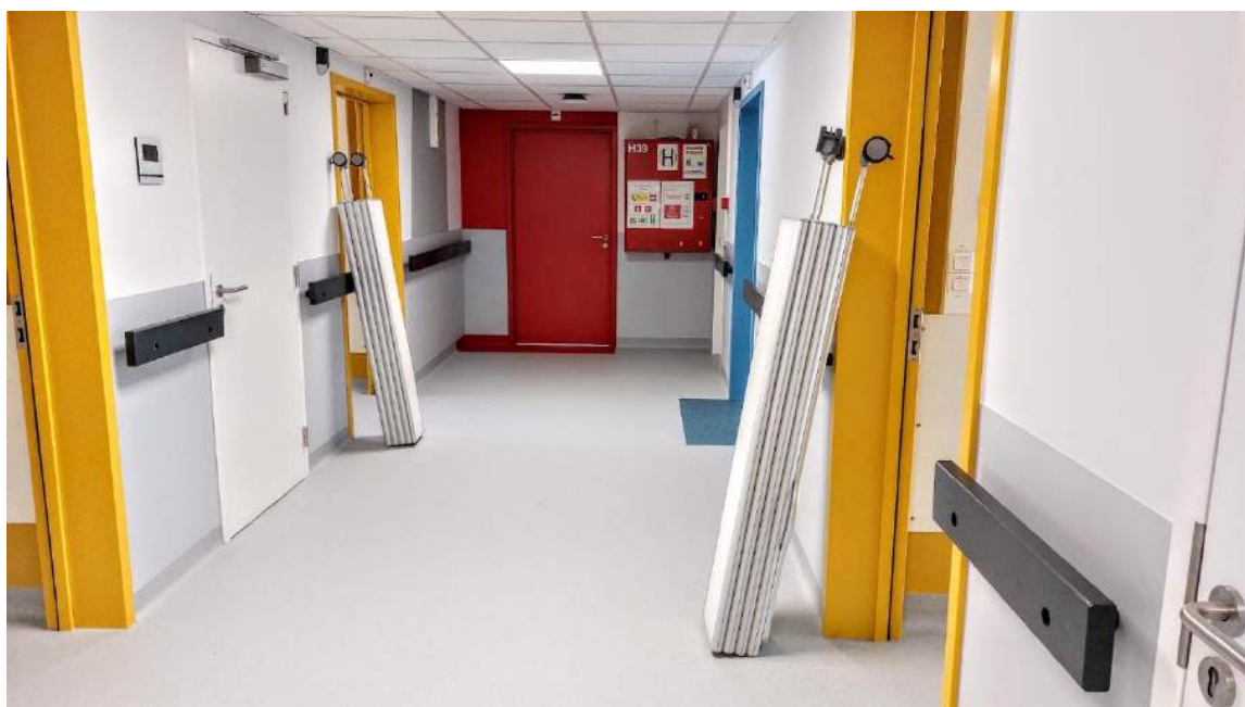
Vorbereidingen ; hier de pré-montage
