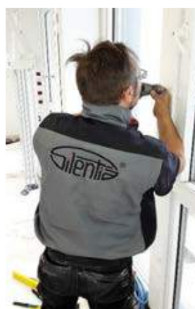
AZ Groeninge Kortrijk : proef- en testopstelling. Bijkomende moeilijkheid, de afKortrijk standhouders moesten hier gemonteerd worden direct op het aluminium raam kozijn d.m.v metaal revetten.
