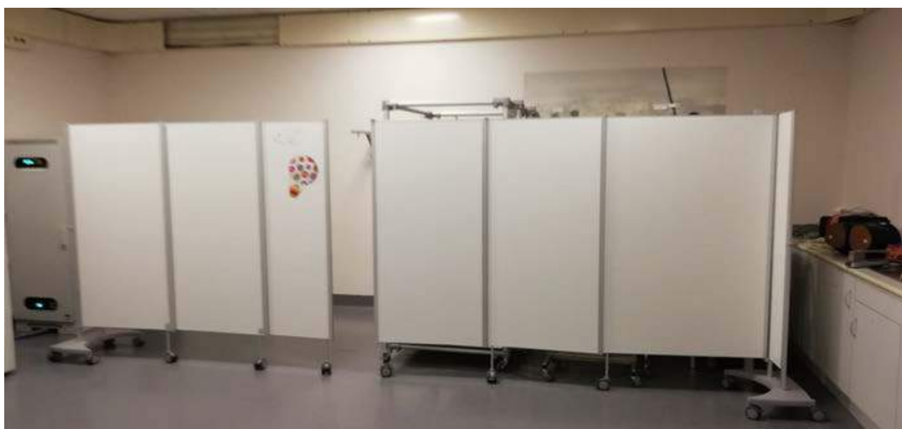
UZ LEUVEN Radio bunker; Aan-eengeklikte strakke panelen vormen hier een "mobiele verplaatsbare wand" en vormen een visuele barrière in de radiobunkler van het UZ Gasthuisberg. Bedoeling was een angst aanjagende apparaat aan het onmiddellijke gezichtsveld van de patiënten te onttrekken.
