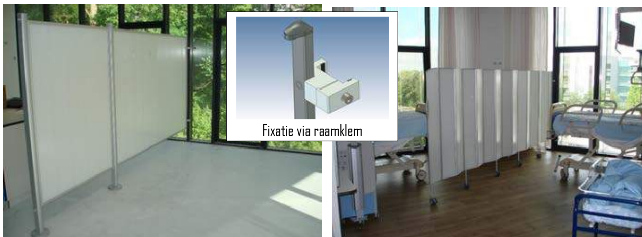
UZA Edegem materniteit : Vaste wand vertrekend vanaf het raamprofiel (beeld links) in een meer persoonskamer vouw scherm gemonteerd op het raamprofiel (beeld rechts) d.m.v een op maat gemaakte raam-klem (centraal beeld)
