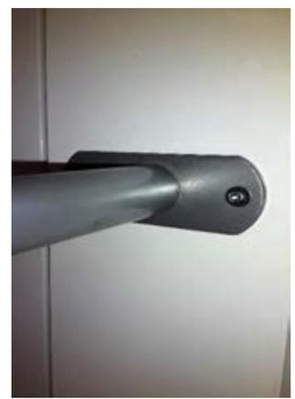
AZ Groeninge Courtrai; montage d'essai aux Urgences ; Une difficulté supplémentaire : les entretoises devaient y être montées directement sur le châssis de fenêtre en aluminium au moyen d'attaches métalliques.
